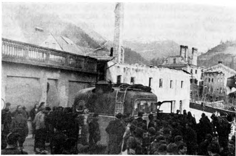
Avtobus, ki je redno vozil na progi Cerkno — Dolenja Trebuša in ki je večkrat prevažal tudi borce Gradnikove brigade.
