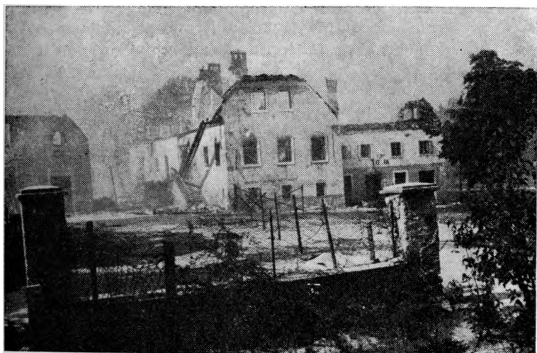
Del frnovrške postojanke po končanem boju
