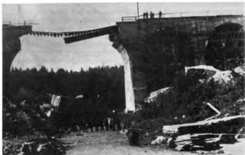
Porušeni Štampetov most
