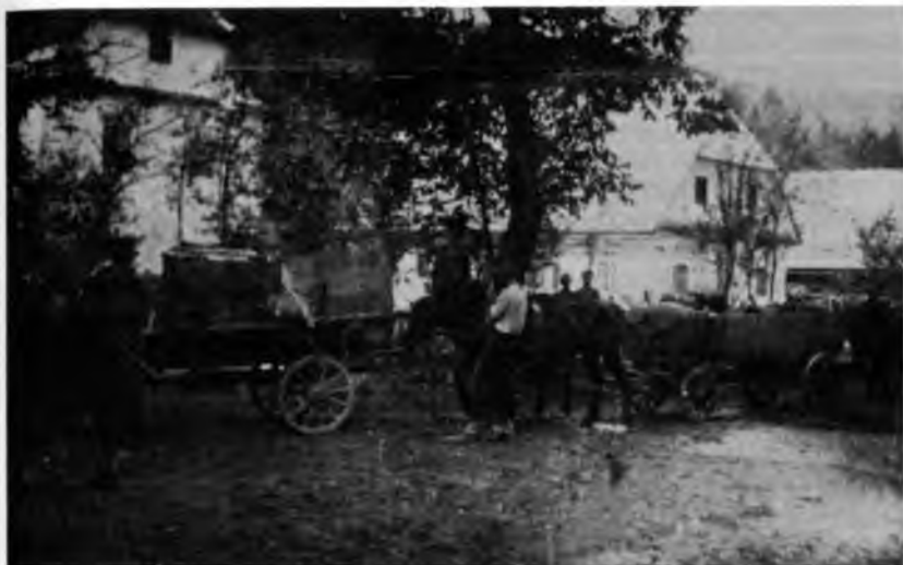
Odvoz zaplenjenega materiala iz Novega mesta na Kočevski Rog
