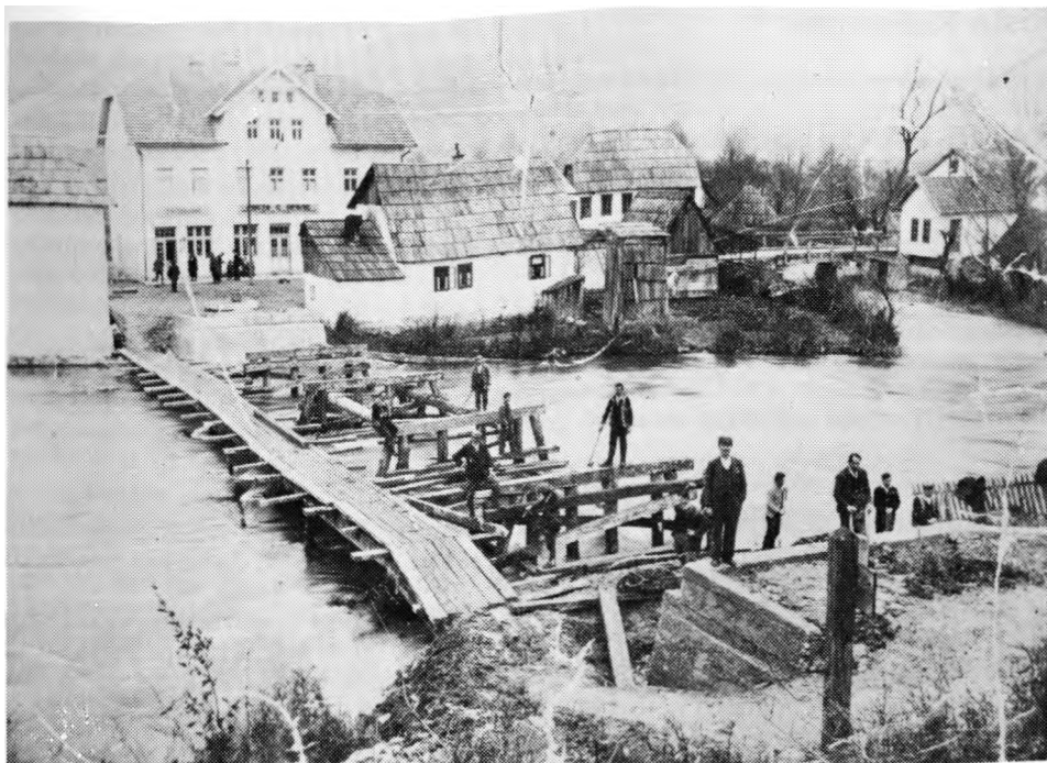
Panorama Šipova (izgradnja mosta na Plivi, 1935-1937. godine)
