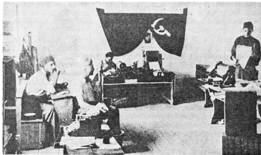
Tehnika NOO-a za Dalmaciju u Brštanovu, kolovoza 1943. gdje su se štampali listovi NOP-a
