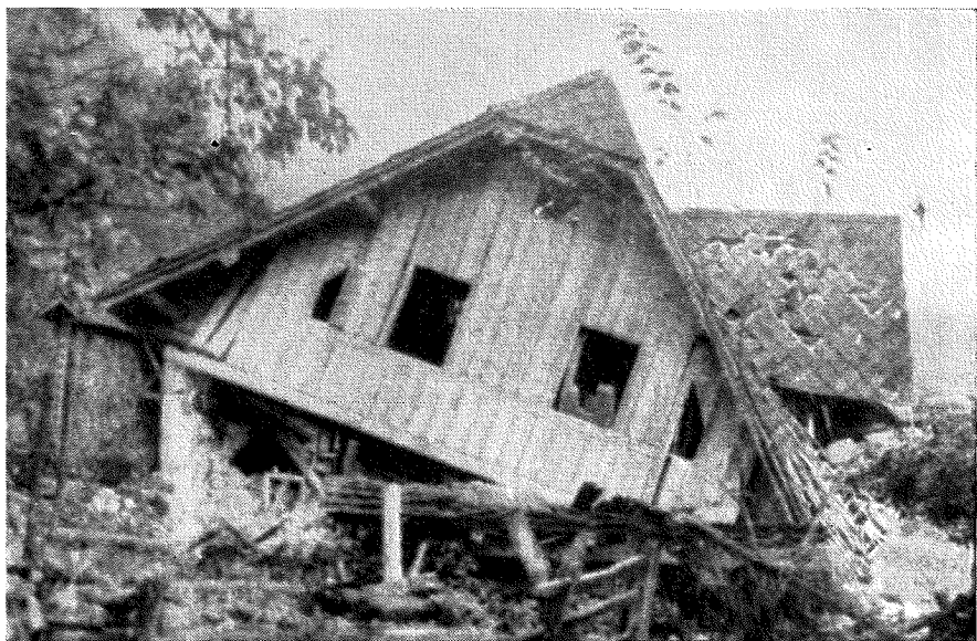
Se pred požigom in pokolom v Srednji Radovni so Nemci minirali nekaj hiš. Na sliki Pangrčeva hiša, ki so jo policisti porušili 12. septembra 1944.
